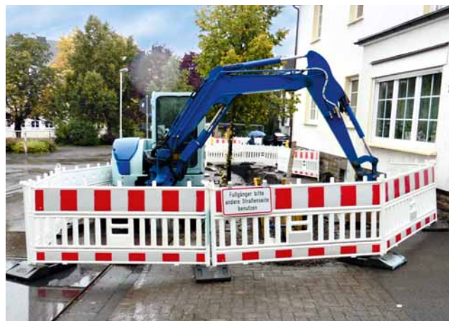
Beispiel: Absperrbarke für den öffentlichen Bereich; gilt nicht innerhalb von Stationen und Anlagen.
